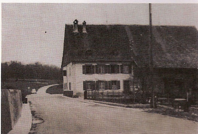
Avant et après la construction du réseau routier interne à Villars-Epeney
