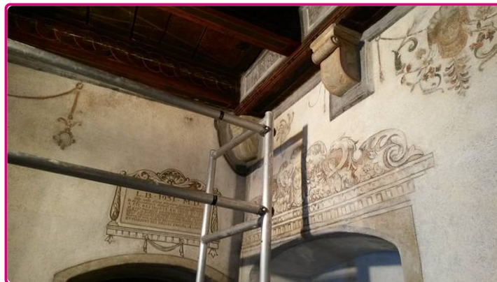
Maison Buttin-de-Loës à Grandvaux, chantier de restauration des peintures de la salle Renaissance
